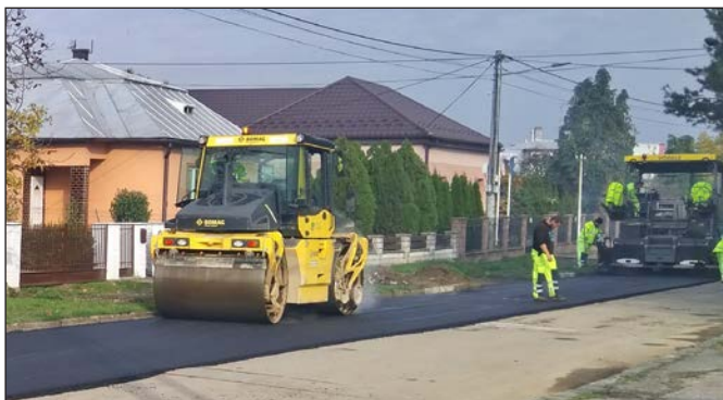
Po Školskej ulici sa už jazdí bezpečnejšie. Miestna komunikácia dostala v októbri novú asfaltovú pokrývku. Snímka: jaci
